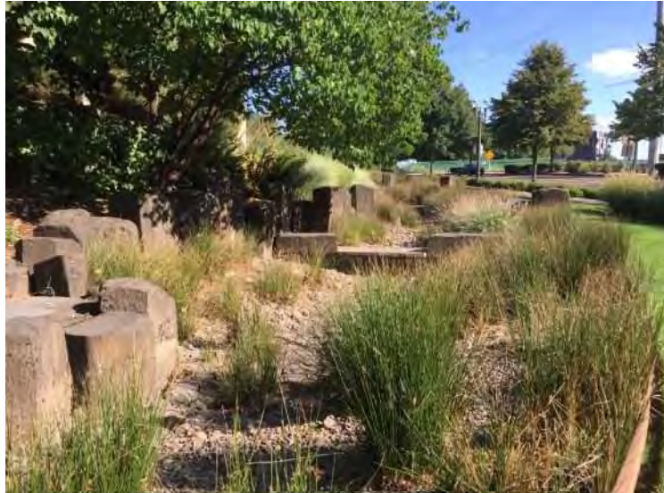
写真-3-2 都市雨水の浄化施設
